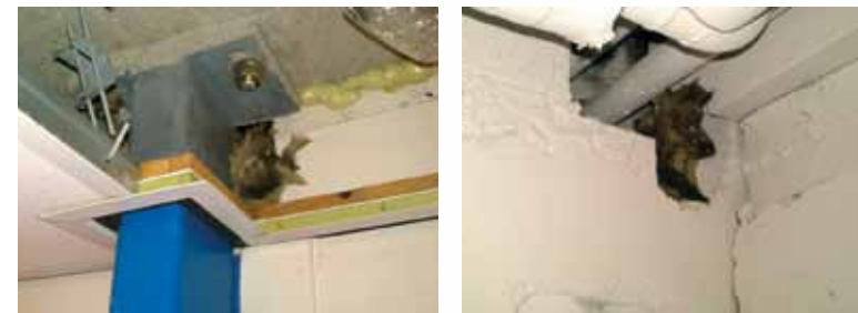
Aangetroffen vervuild isolatiemateriaal uit verborgen constructieve delen.
